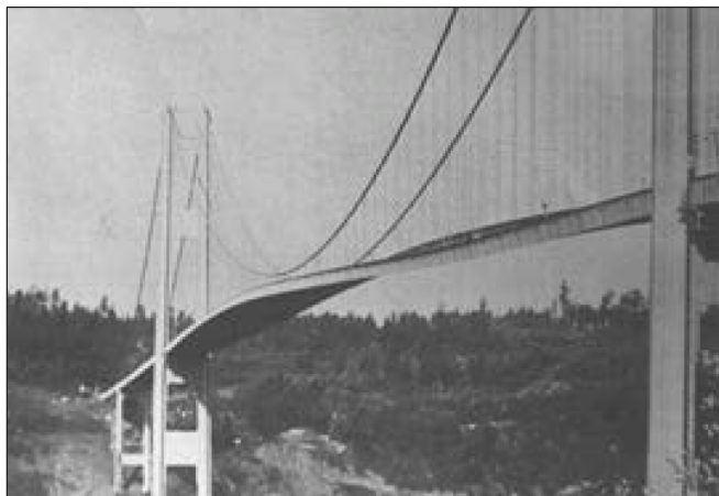
13. ábra: A Tacoma híd hullámzó mozgása (internet)
