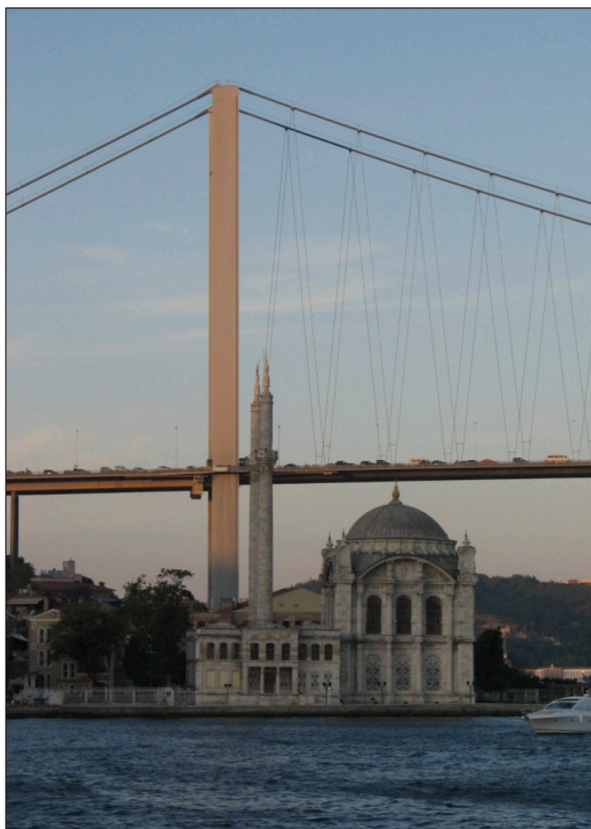
16. ábra: A Boszporusz híd a rácsostartó szerű függesztő kábelekekkel (Internet)
