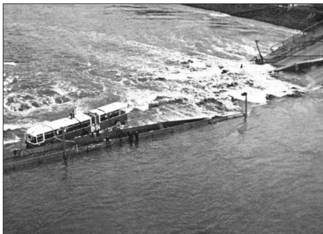
3. ábra: Az összeomlott Reichsbrücke a folyóban (internet)
